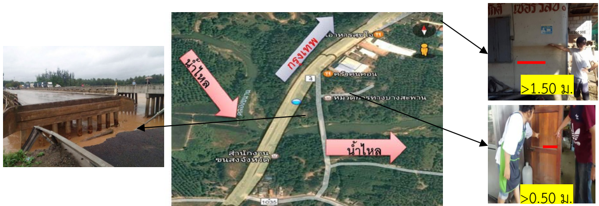
รูปที่ 6 สภาพน้ำท่วมและความเสียหายบริเวณสะพานคลองวังยาว อ. บางสะพาน
