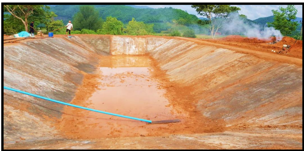
ภาพก่อสร้างแล้วเสร็จ
