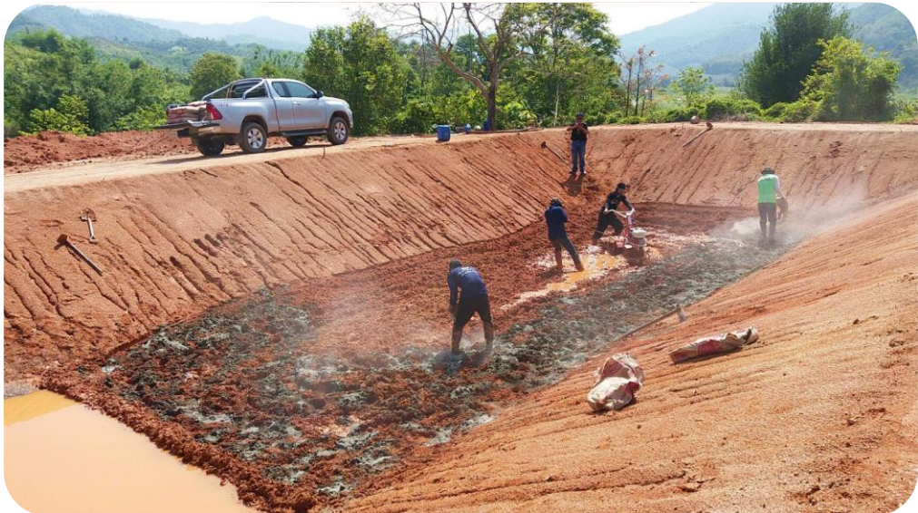
ภาพการทำซอยซีเมนต์กันบ่อ คลุกเคล้าดินและปูนซีเมนต์ให้เข้ากันพร้อมให้ความชื้น
