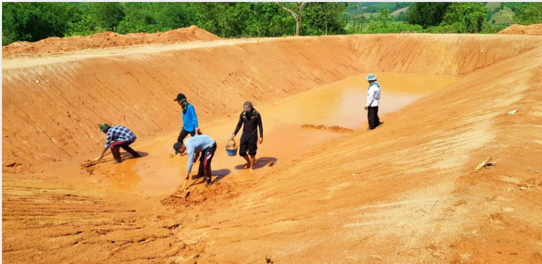
การชุดบ่อก่อสร้างและชุดเปิดหน้าดิน
