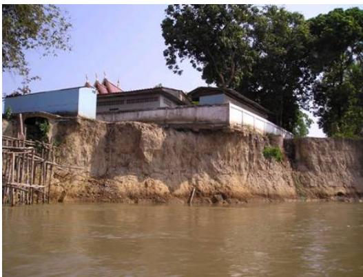
ภาพที่ 1 การพังทลายของตลิ่งในแม่น้ำกจ. เชียงราย
