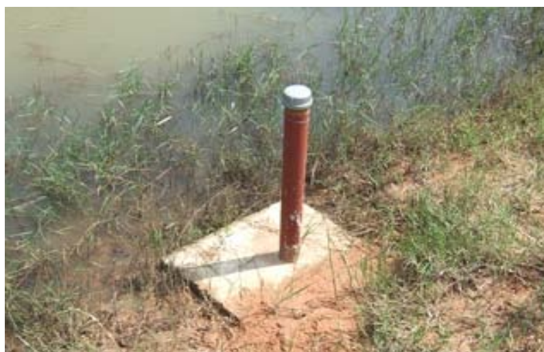
รูปที่ 4. ท่อพิโซมิเตอร์ (piezometer)
