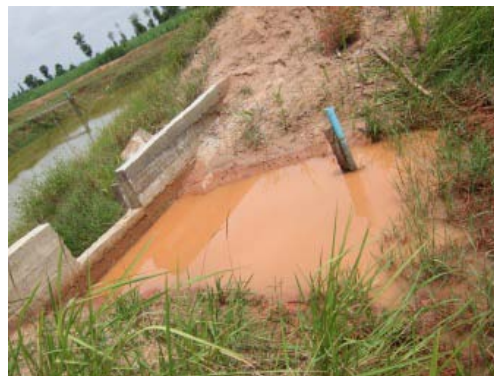
รูปที่ 5 ฝายสันคมสี่เหลี่ยมและเครื่องวัดระดับน้ำ
