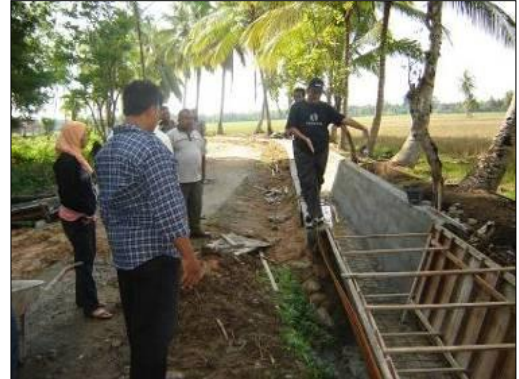
Plate 5 Construction training at start of WUA contracts (La formation des construction au début de contrats WUA)
