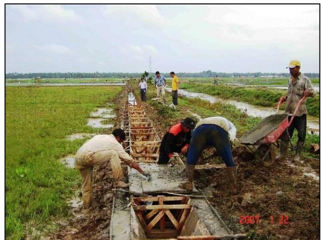
Plate 7 WUA building their lined canal (L'AUE construit leur ligne de canal).
